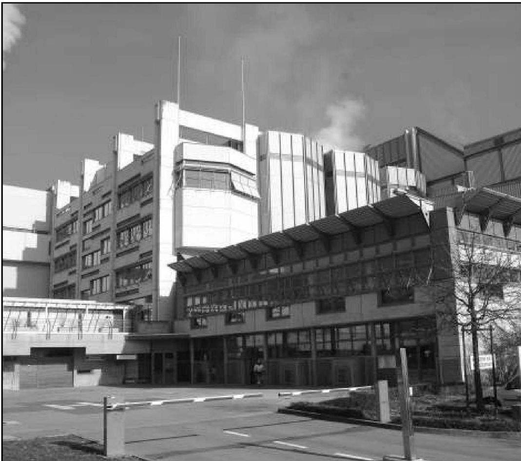
L'usine d'incinération de Cheneviers. JPDS
